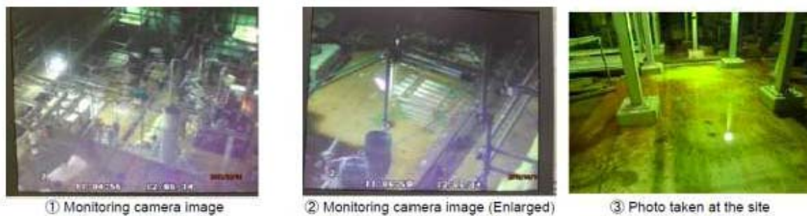
شکل ۲۹. تصاویر دوربین امنیتی از نشستی پیدا شده در ۱۴ ژوئن در تجهیز رفع آلودگی سیستم گردش تصفیه
