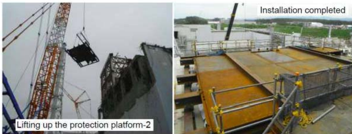
شکل ۲۱. نصب صفحه حفاظتی حوضچه سوخت مصرف شده یونیت ۴ (قسمت دوم)
