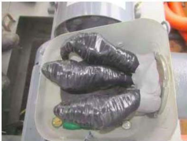
شکل ۱۸. ترمینال پمپ بعد از تعمیر
