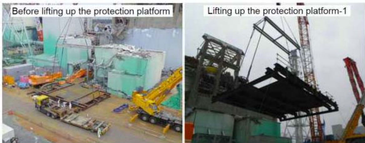
شکل ۲۰. نصب صفحه حفاظتی حوضچه سوخت مصرف شده یونیت ۴ (قسمت اول)
