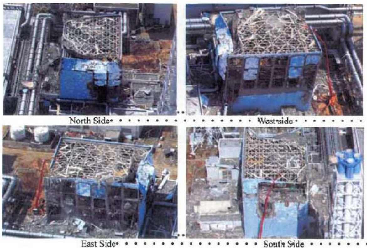
شکل ۹. وضعیت دیوارهای بیرونی
