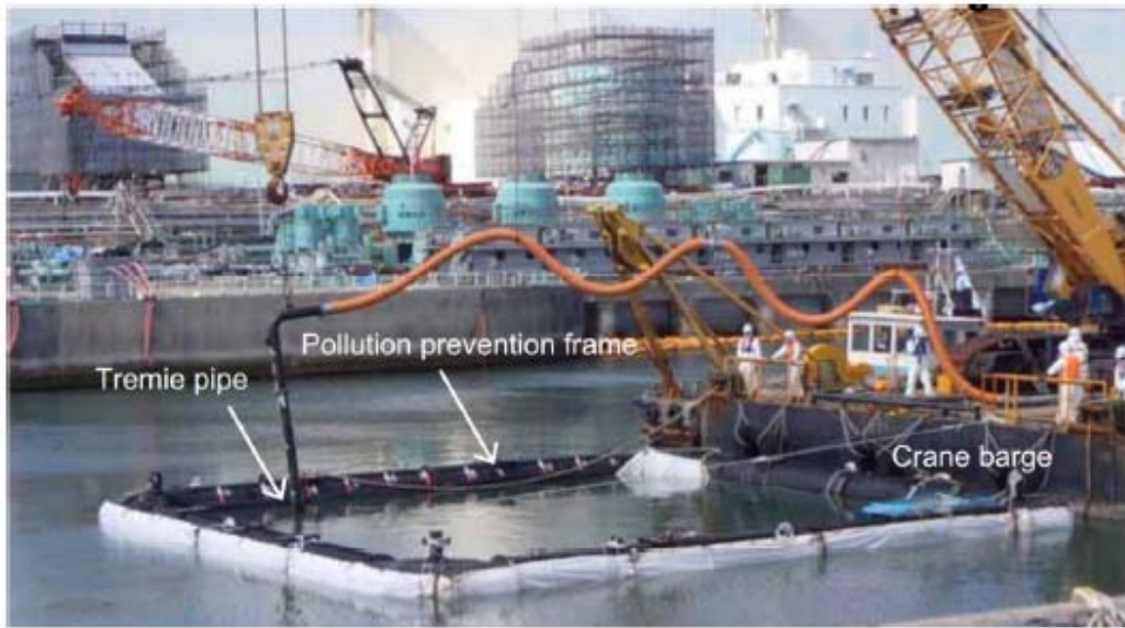
شکل ۲۵. مقدمات برای عملیات تست پوشش خاک دریا
