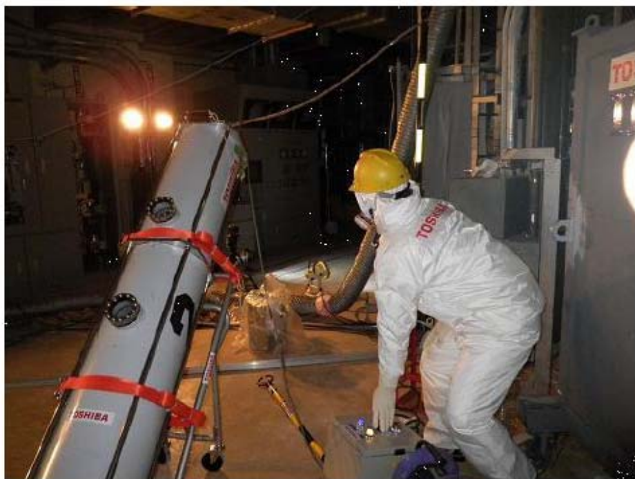
شکل ۸. کارکنان که اندوسکوپ را به یونیت ۲ داخل می‌کنند
