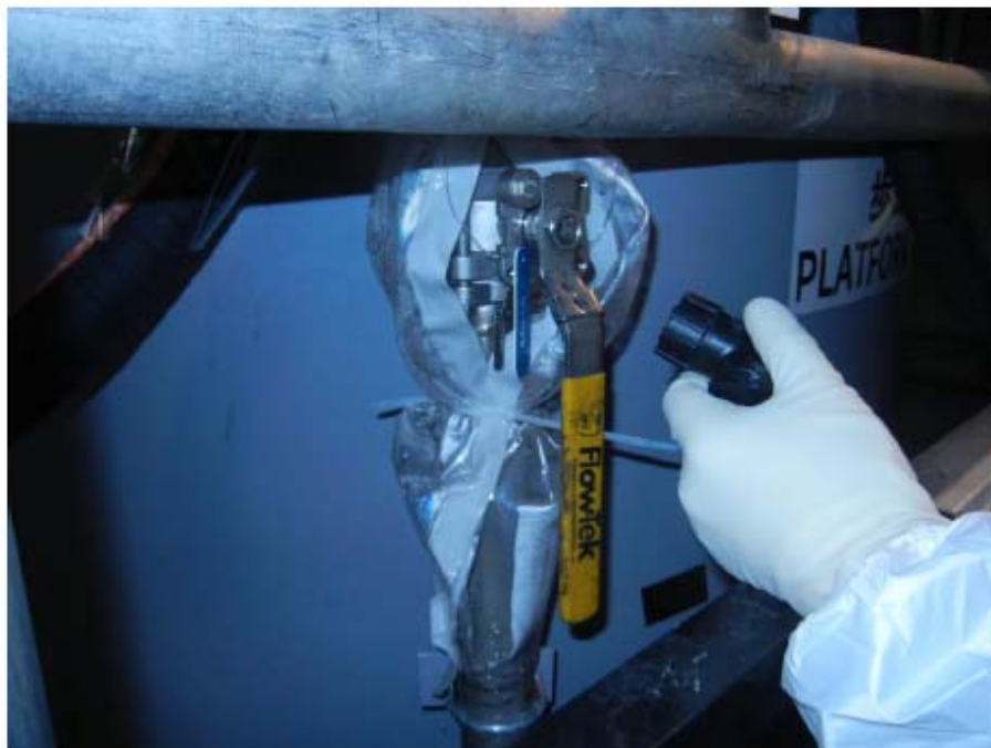
شکل ۱۸. محل نشتی کشف شده در ۲۵ فوریه
