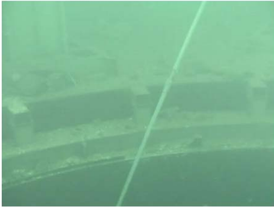
شکل ۱۳. کف چاهک راکتور (از زاویه افقی عکسبرداری شده است)
