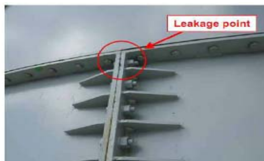
شکل ۱۳. محل نشت در فیلتر غشاء اسمز معکوس (از ۶ فوریه)
