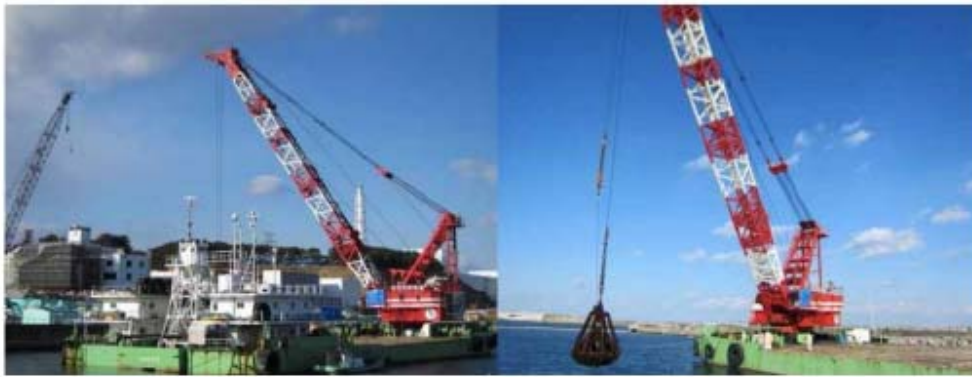
شکل ۱۷. جرثقیل که برای برداشت مواد از کانال ورودی یونیت‌های ۱ تا ۴ استفاده می‌شود
