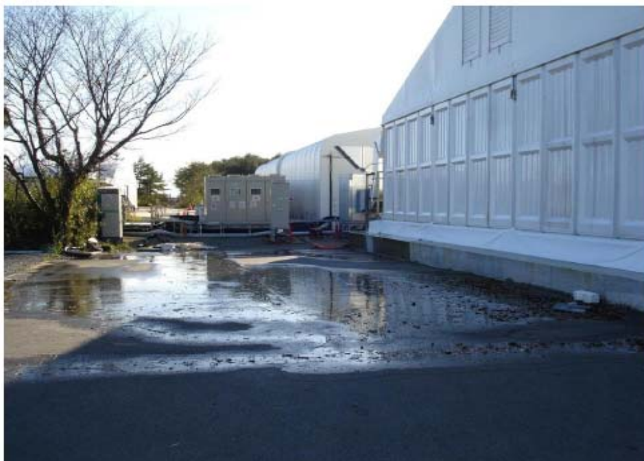
شکل ۵. محل انباشته شدن آب نشت یافته از دستگاه تغلیظ تبخیری در خارج از ساختمان
