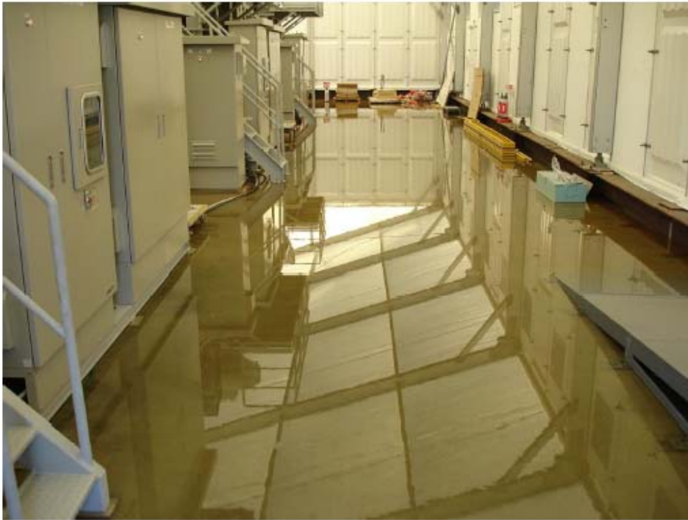
شکل ۳. وضعیت نشتی پیدا شده در دستگاه تغلیظ تبخیری
