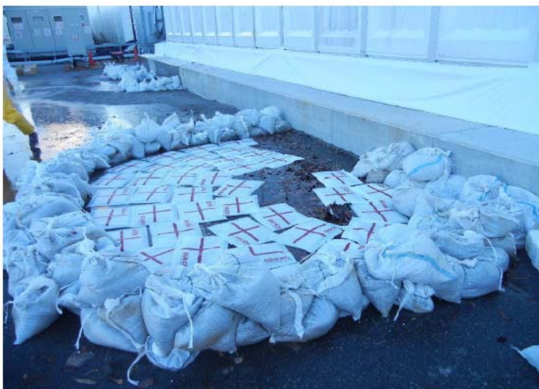
شکل ۶. کیسه‌های شن که برای کنترل نشت از دستگاه تغلیظ تبخیری استفاده شده است
