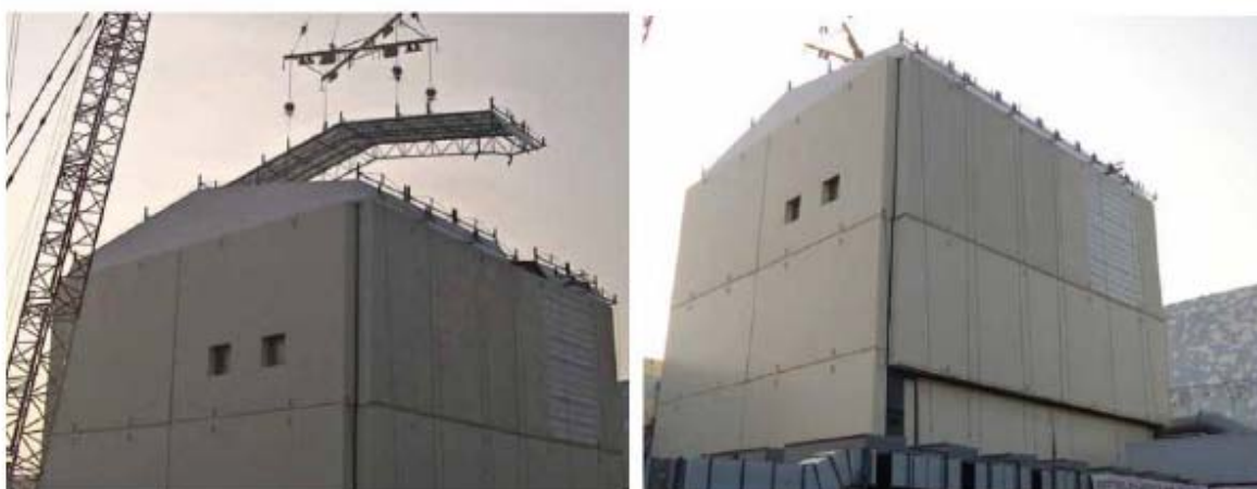
شکل ۳. پوشش تکمیل شده ساختمان یونیت ۱
