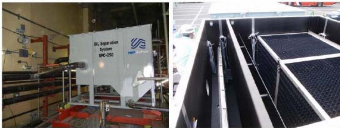
شکل ۱۴. قسمت بیرونی و داخلی تجهیز جداسازی روغن
