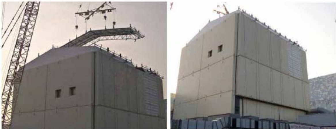
شکل ۳. پوشش تکمیل شده ساختمان یونیت ۱
