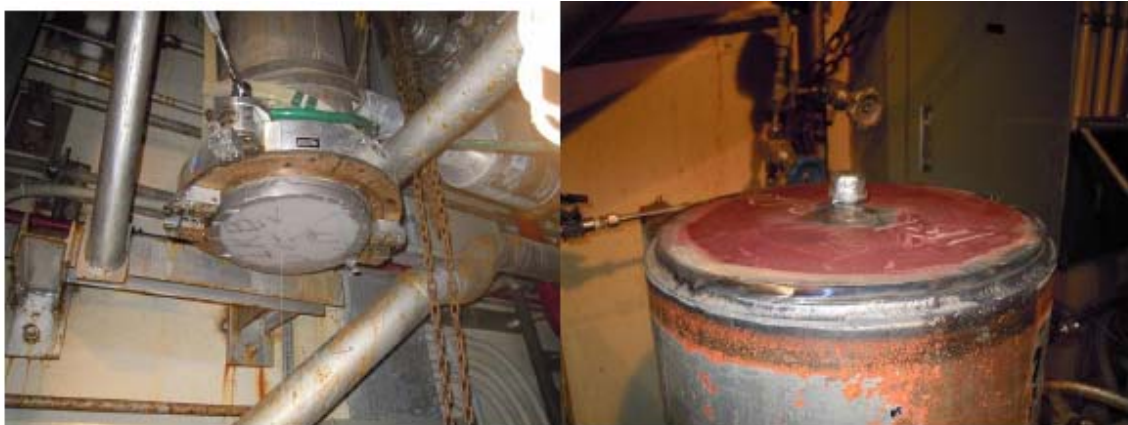
شکل ۲. لوله‌کشی بریده شده در یونیت ۱ برای نصب سیستم مدیریت گاز
