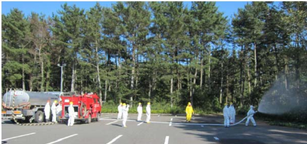
شکل ۱۱. کارکنان TEPCO که آب انباشته شده تصفیه شده یونیت‌های ۵ و ۶ را برای کاهش گرد و خاک و جلوگیری از آتش‌سوزی اسپری می‌کنند
