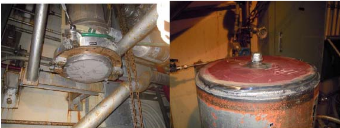
شکل ۳. برش لوله در یونیت ۱ برای نصب سیستم مدیریت گاز
