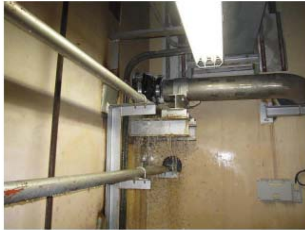
شکل ۵. آب نشت کننده به یونیت ۶ در ۲۱ سپتامبر
