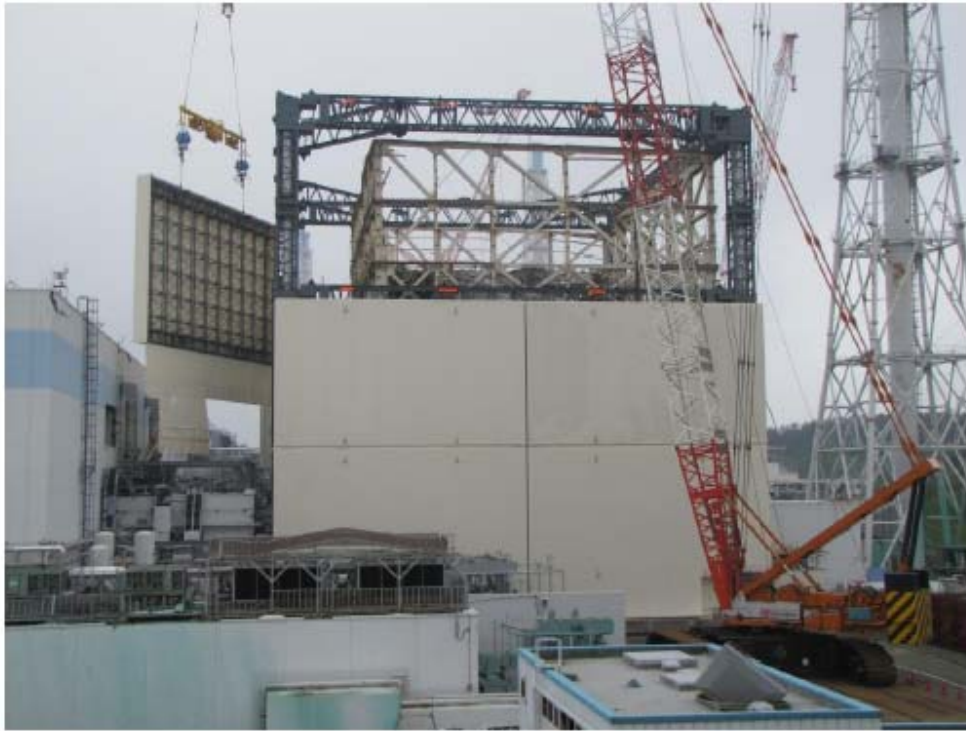
شکل ۴. پیشرفت ساخت پوشش برای یونیت ۱ (دیوار در محل قرار داده می‌شود)
