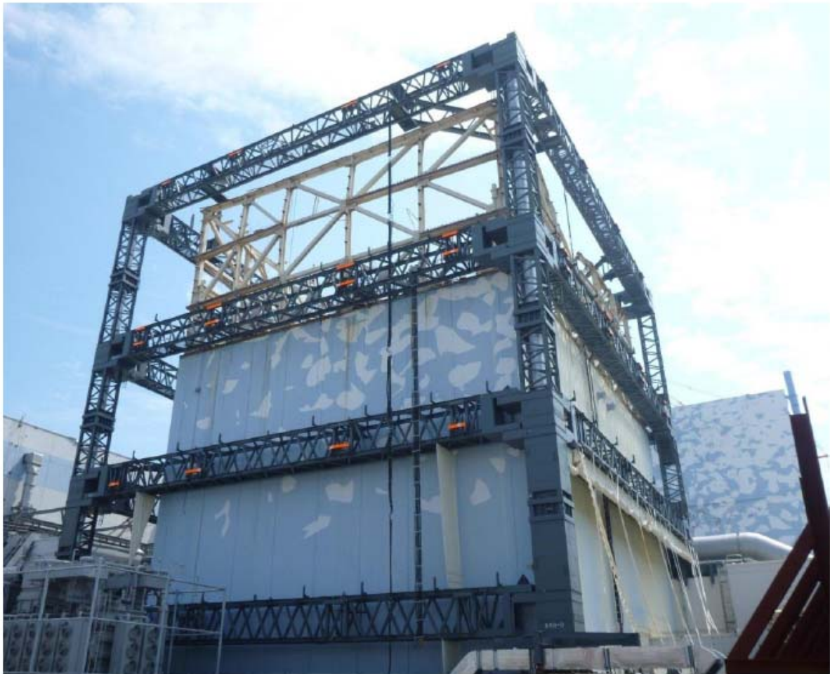
شکل ۳. ساختار اولیه تکمیل شده پوشش یونیت ۱
