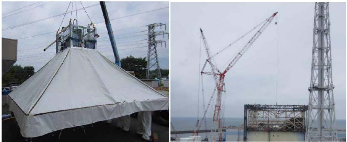
شکل ۴. نمونه برداری گرد و خاک از قسمت بالانتر یونیت ۱
