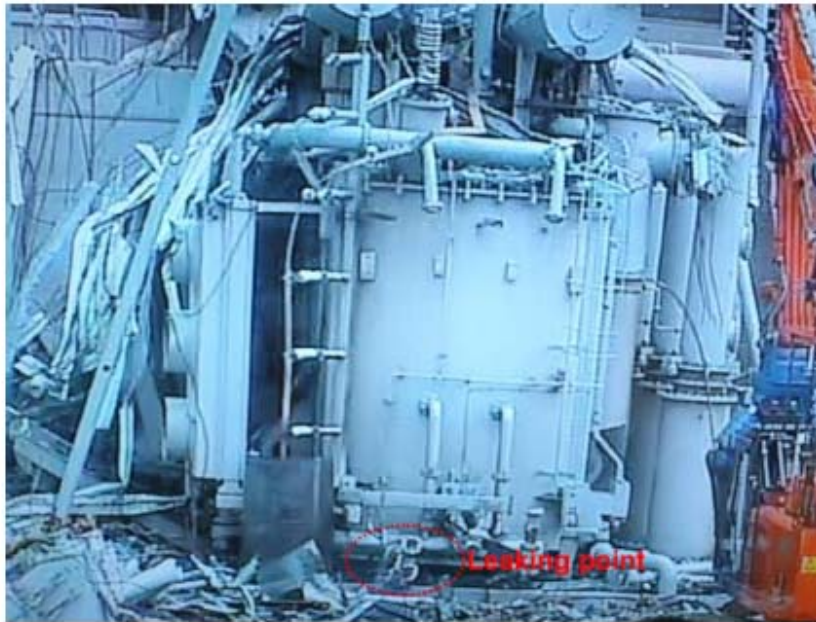
شکل ۳. عکس محل نشت روغن بر روی ترانسفورماتور اصلی یونیت ۳
