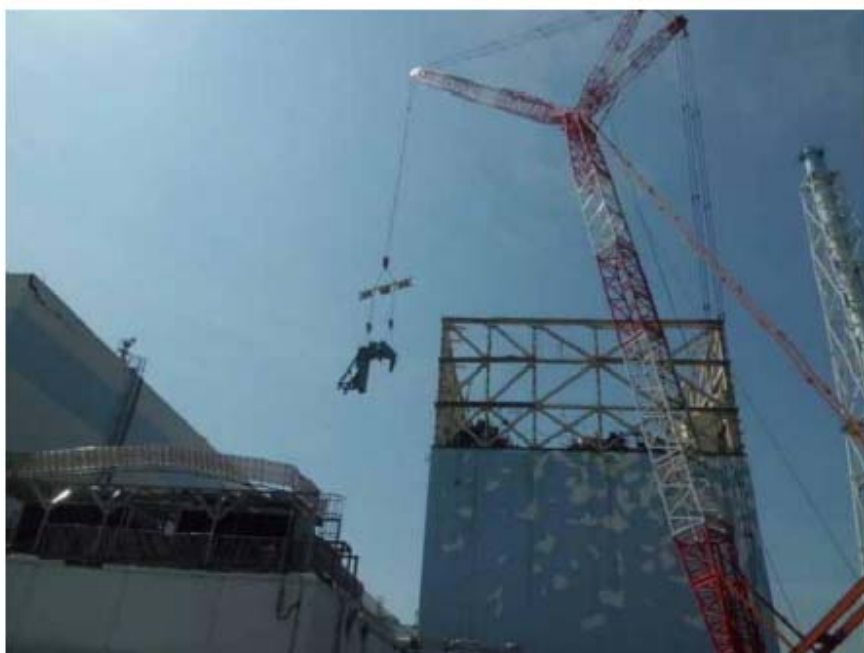
شکل ۳. جرثقیل اجزاء را برای ساخت چارچوب آهنی برای یونیت ۱ جابجا می کند (از ۱۰ آگوست)
