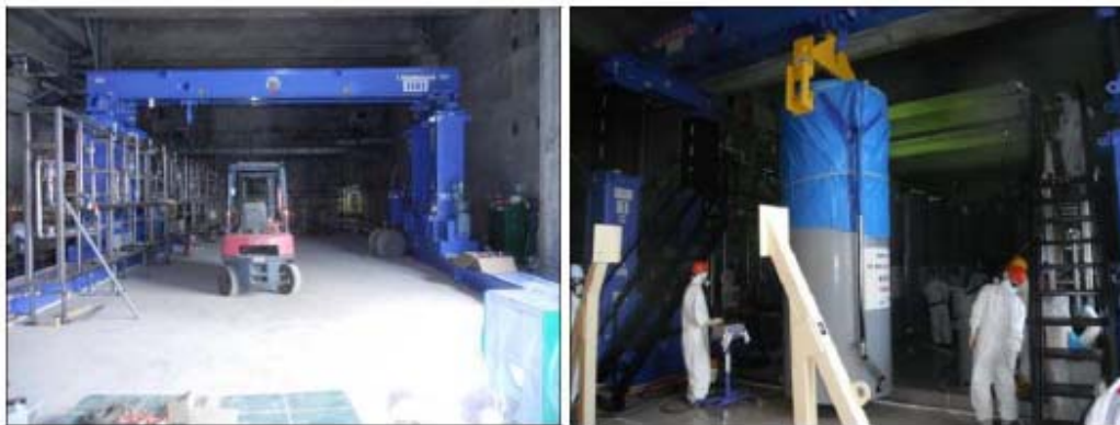
شکل ۱۱. تصاویر SARRY در طی نصب
