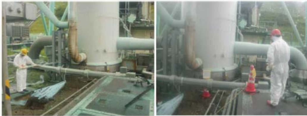
شکل ۱۳. کارکنان در ناحیه با دز بالا در برج تخلیه اصلی بین یونیت ۱ و ۲ اندازه‌گیری انجام می‌دهند
