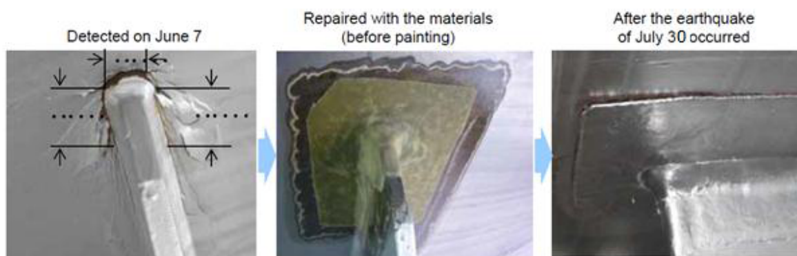
شکل ۵. نشت هوا از کانال انتشار اصلی یونیت ۴ - تعمیر اصلی و خسارت جدید
