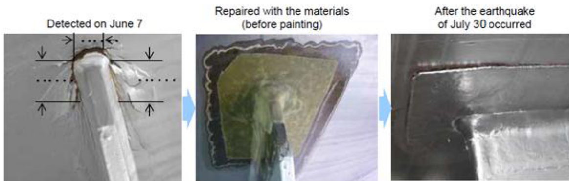
شکل ۲. نشت هوا از کانال انتشار اصلی یونیت ۴ - تعمیر اصلی و خسارت جدید
