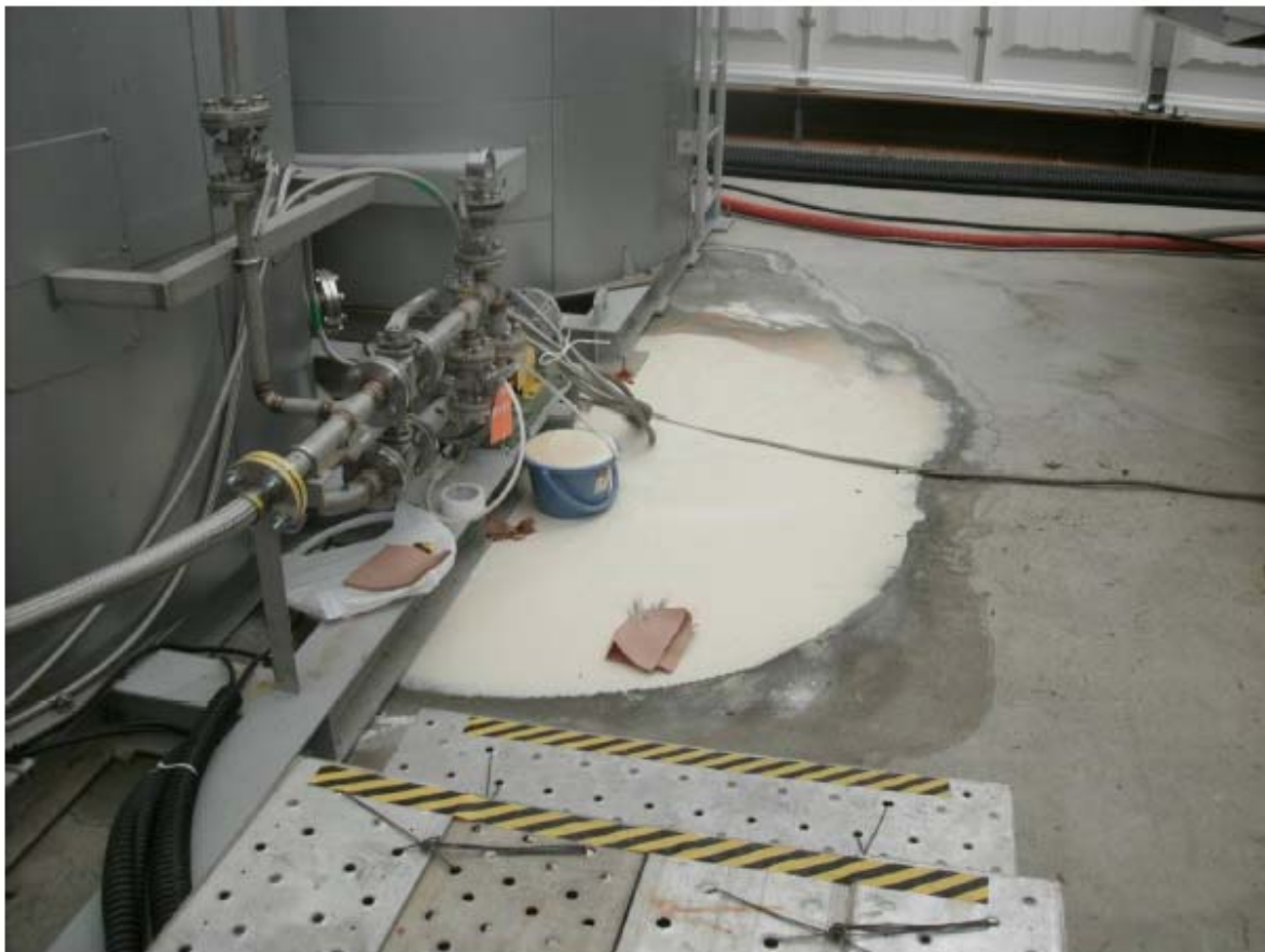
شکل ۵. نشت آب از خط نمونه برداری دستگاه تغلیظ تبخیری مورخ ۱۲ دسامبر
