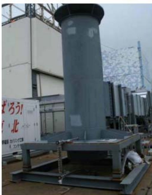
شکل ۵. برج تخلیه پوشش ساختمان راکتور یونیت ۱
